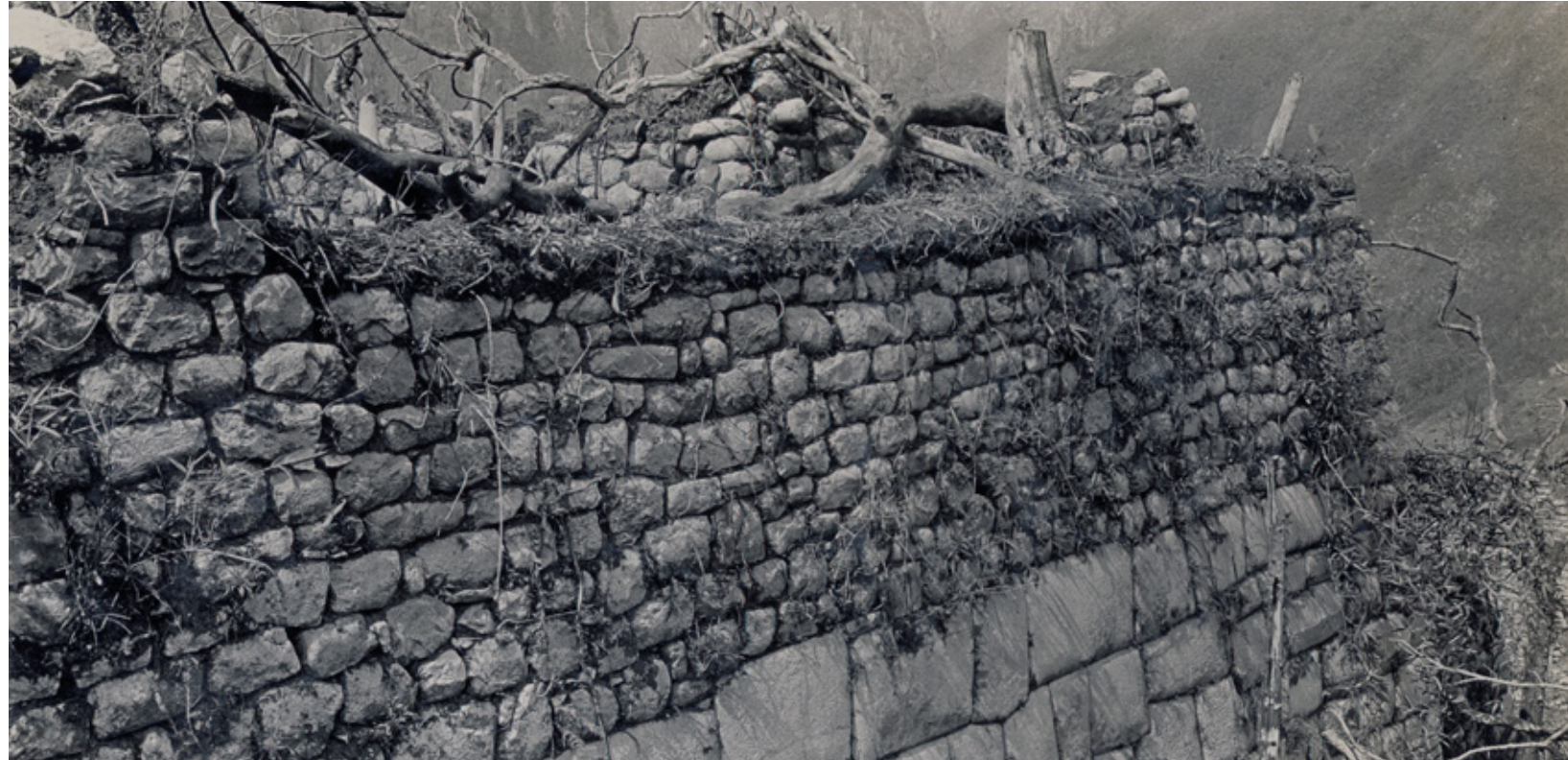
Muro del conjunto 35, donde se aprecia la diferencia entre los mampuestos del muro (fotografía: EPY; cortesía de National Geographic Society).
